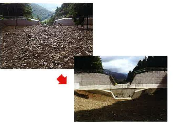
平成二十九年八月七日、台風五号に起因する線状降水帯によるゲリラ豪雨が流入しました。施工中の土石流対応型谷止工で下流への被害は防ぐことができましたが、一晩の雨による流入土砂で谷止工上部は、満杯となり、現場の様相は一変しました。
